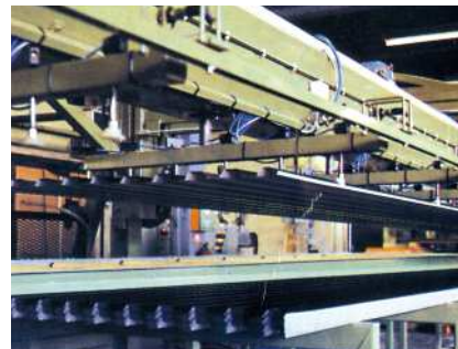
Innan KONISOL appliceras rengörs all byggplåt grundligt.
